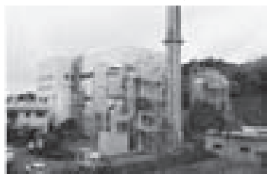
▲現在の焼却炉
