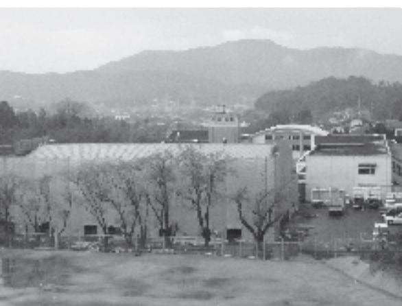
▲建設中の川崎東小学校体育館
