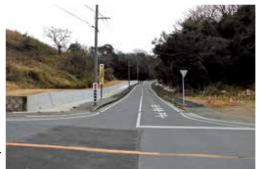
給食センターへ続く町道▶ (左側の法面工事)
