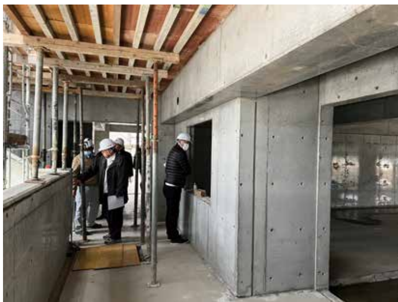
▲建設中の豊州改良住宅
