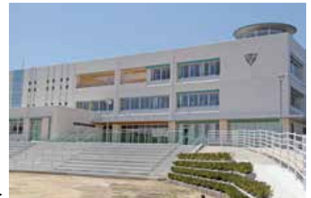
改修の終わった 川崎中学校▶
