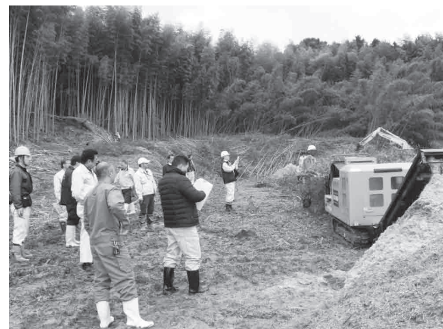
▲竹破碎機の作業風景
