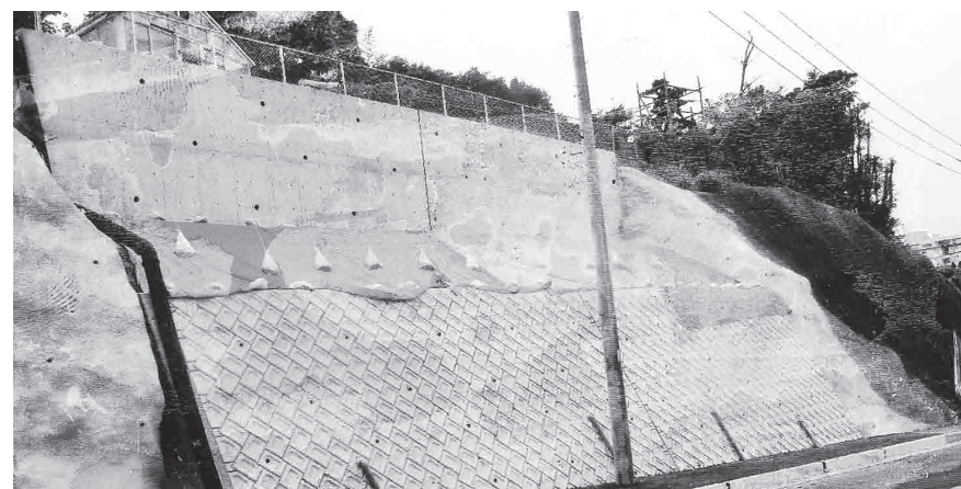
▲復旧後の町道岩鼻田川線
