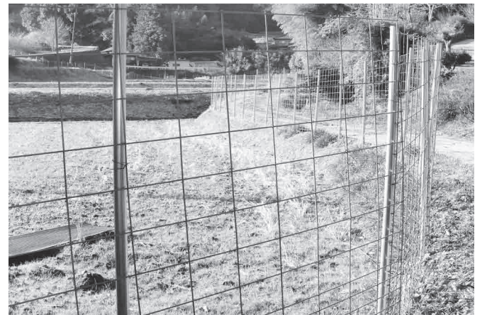
設置された防護柵(安宅地区)▶
