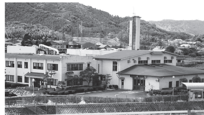
▲現在稼働中の乙女環境センター
