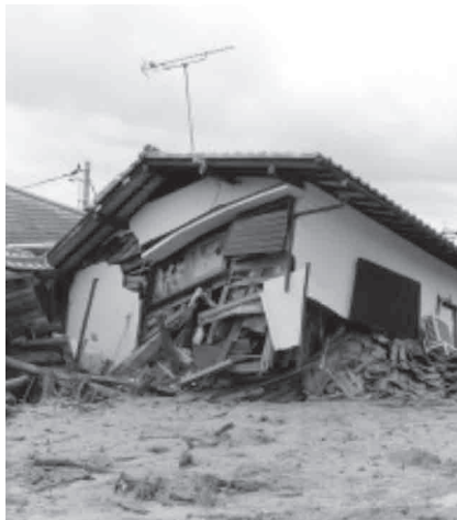
▲倒壊した家屋
