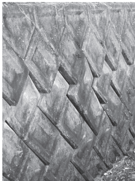
▲石橋池の側面にできた膨らみ
