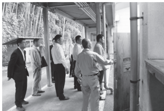
▲発電機の状態を確認
