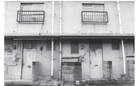
▲除却予定の豊州団地
