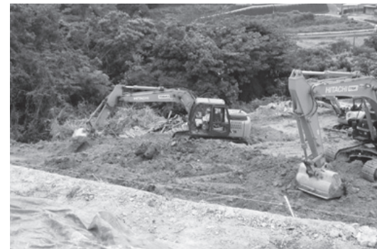
▲崩落した道路の復旧工事の様子
