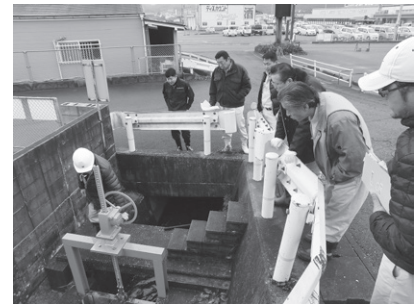
◀森安地区水門
